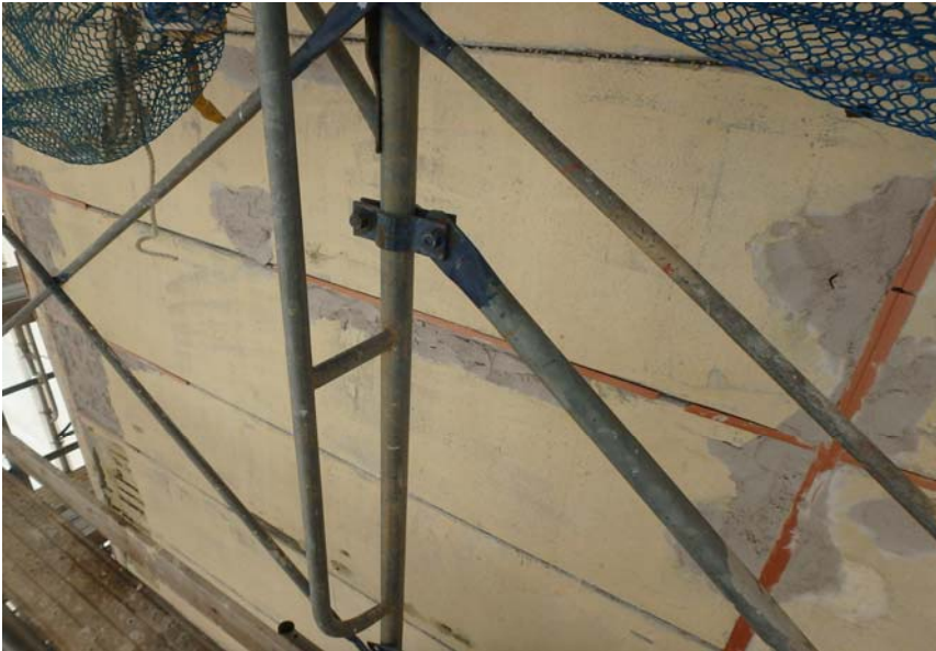
1号棟外壁修繕
