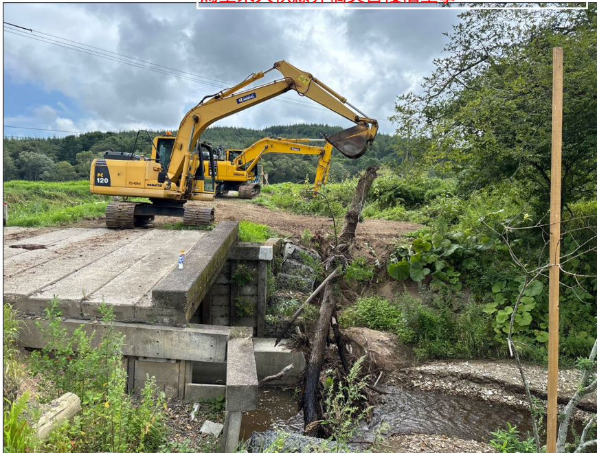
馬主来大秋線界橋災害復旧工事
