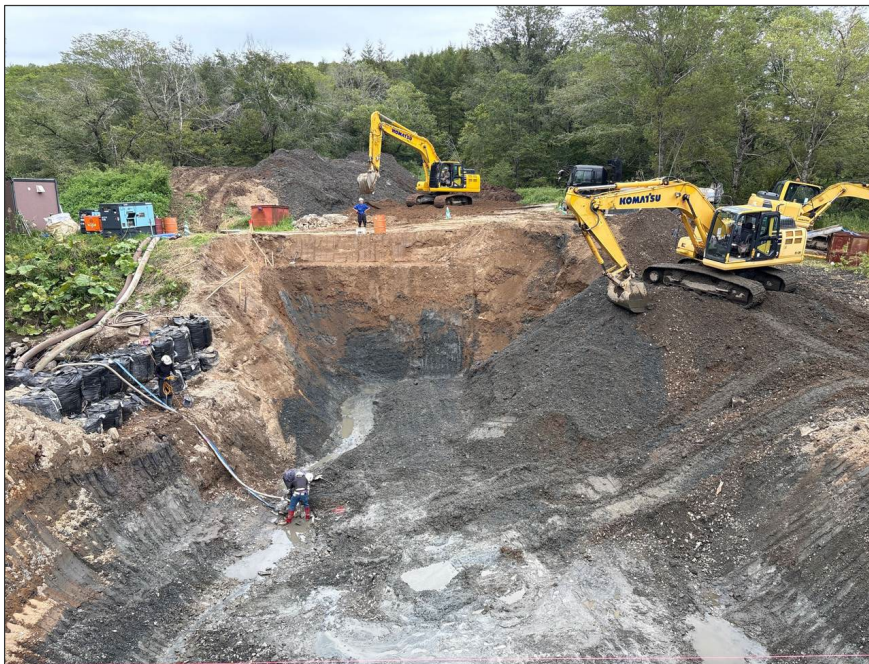
馬主来大秋線界橋災害復旧工事
