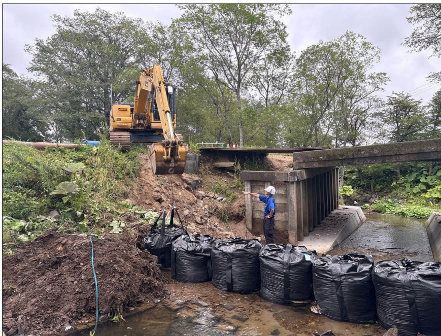
馬主来大秋線界橋災害復旧工事
