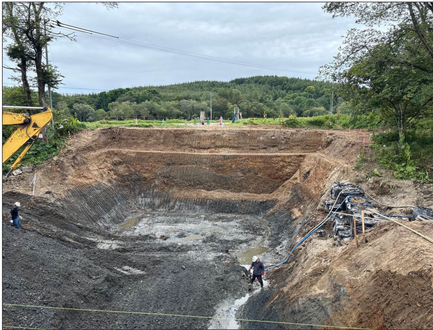
馬主来大秋線界橋災害復旧工事
