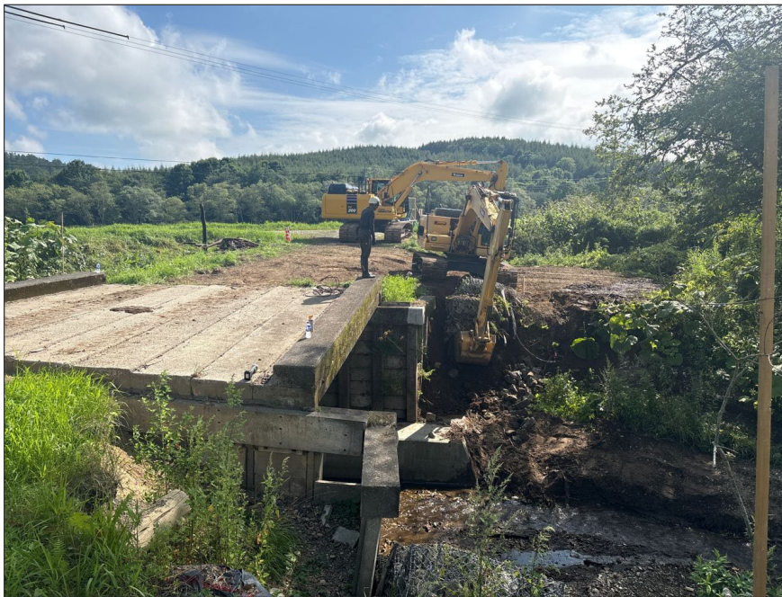
馬主来大秋線界橋災害復旧工事
