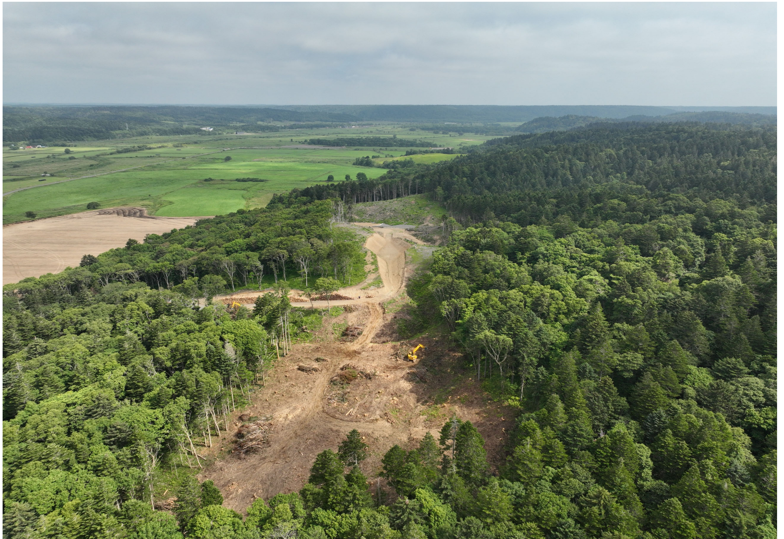
苫多西工区 8月空撮P=4000.00～
