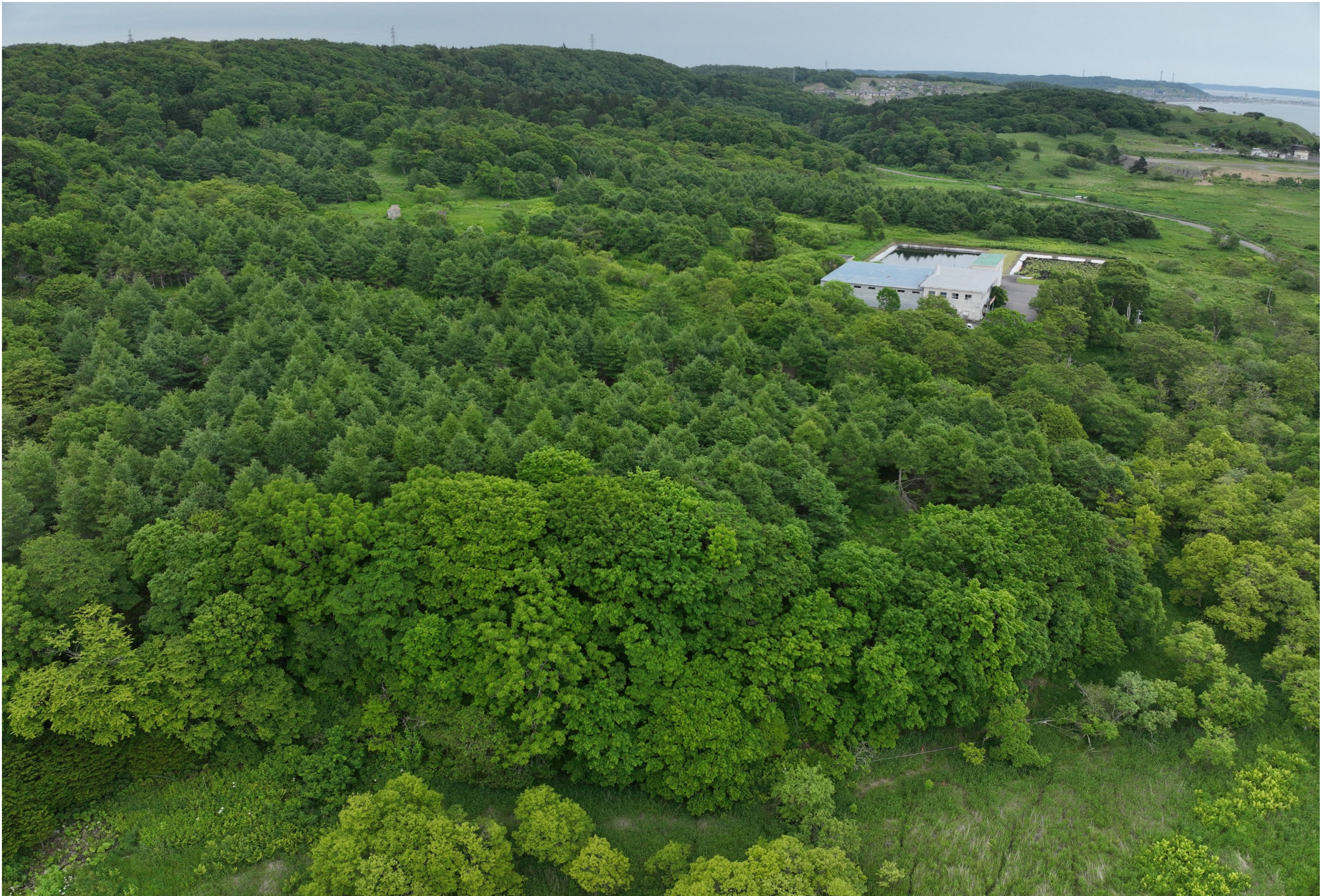
太田宏陽工区 空撮 起点側～
