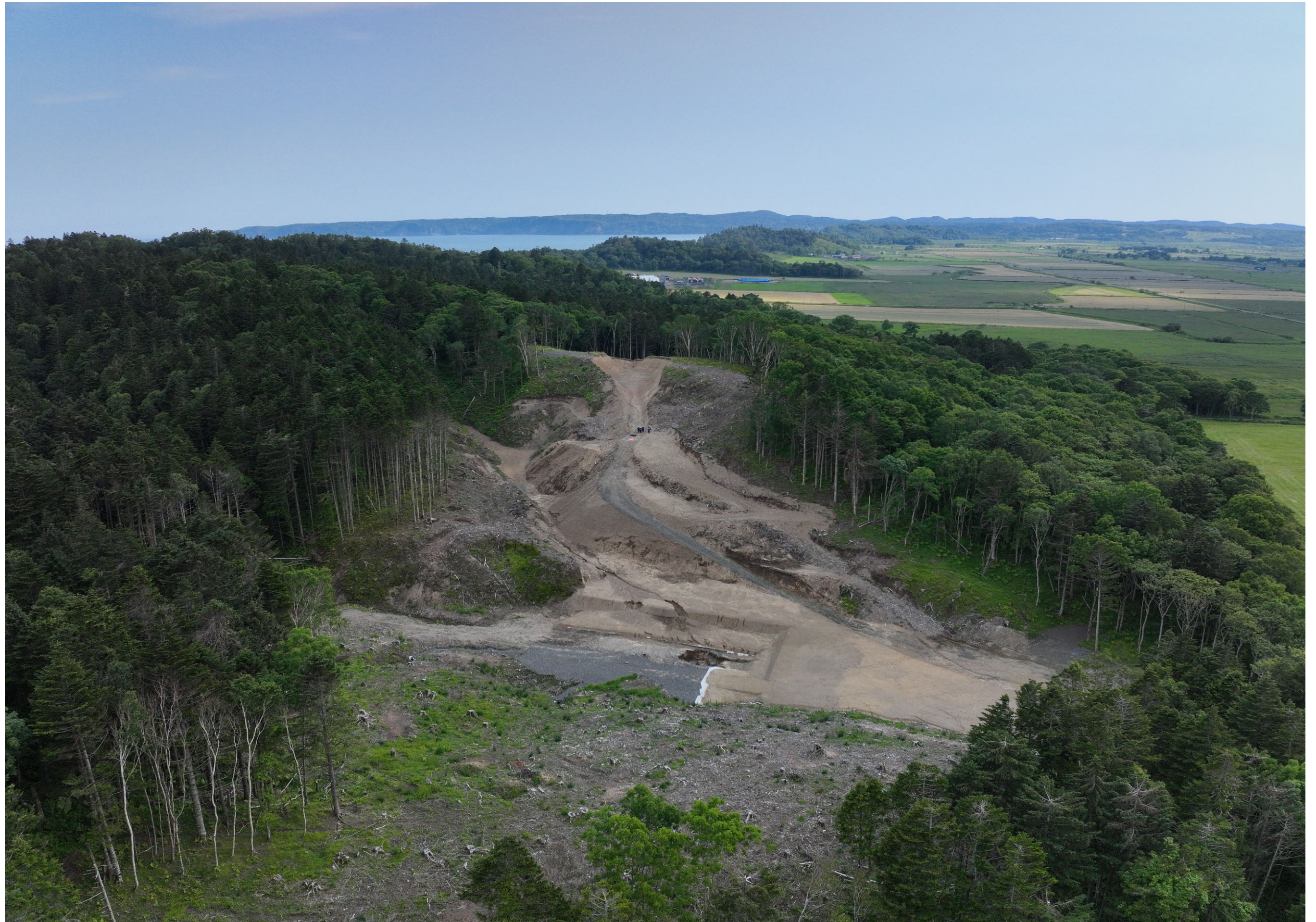
苫多西工区 7月空撮 終点側～
