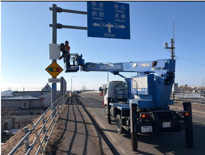
白糠跨線橋に恋問館看板設置
