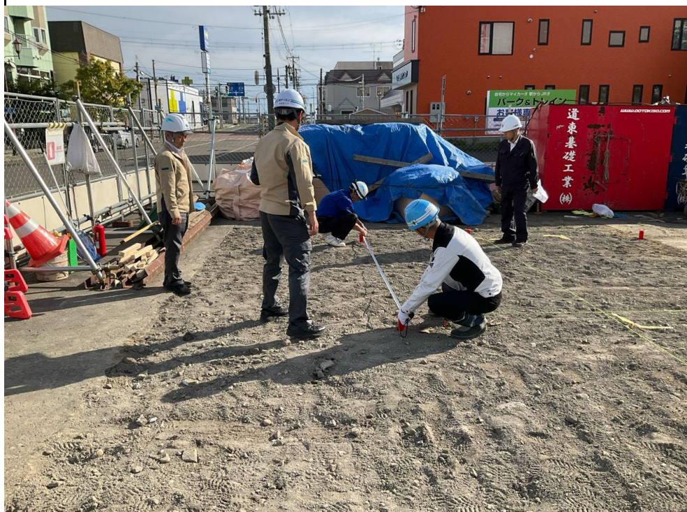
杭工事（杭芯検査）
