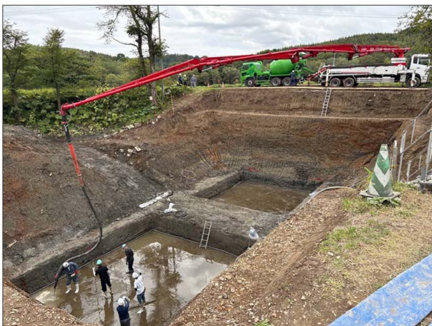
馬主来大秋線界橋災害復旧工事
