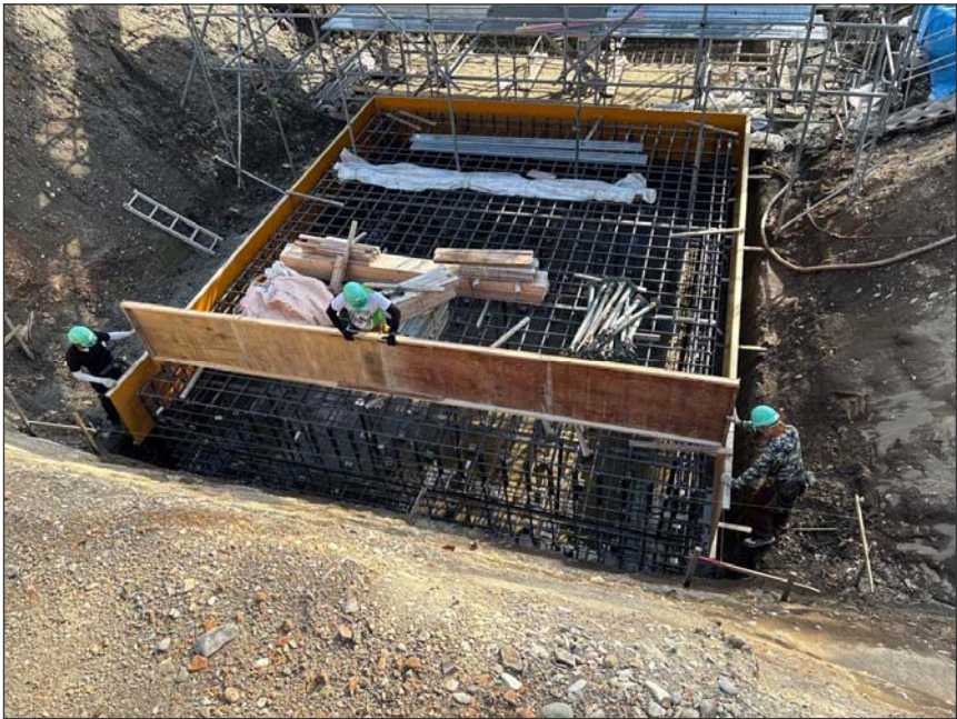
馬主来大秋線界橋災害復旧工事
