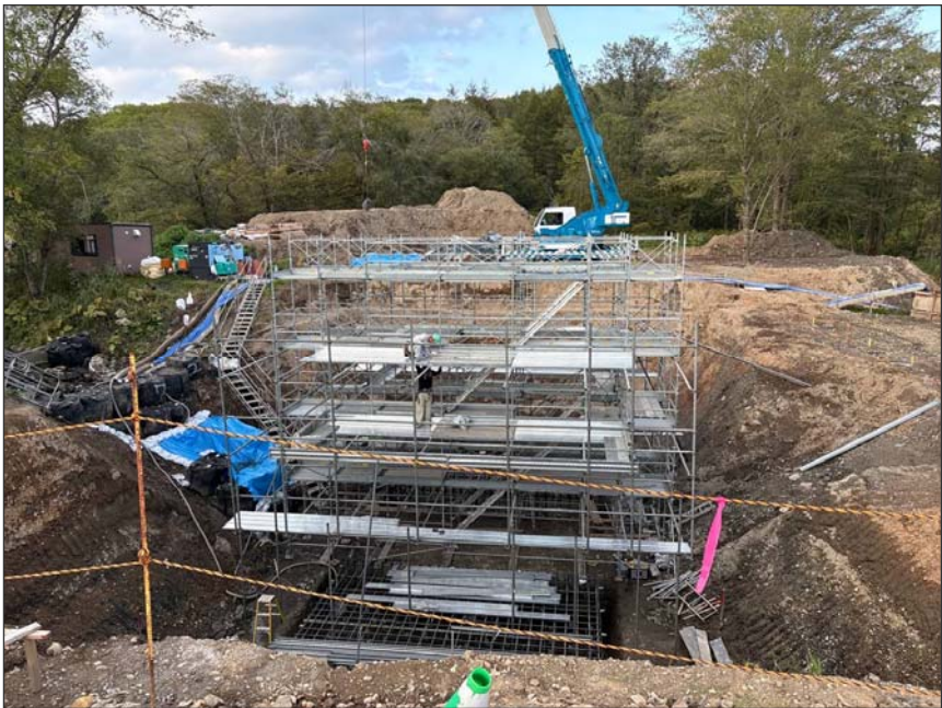
馬主来大秋線界橋災害復旧工事
