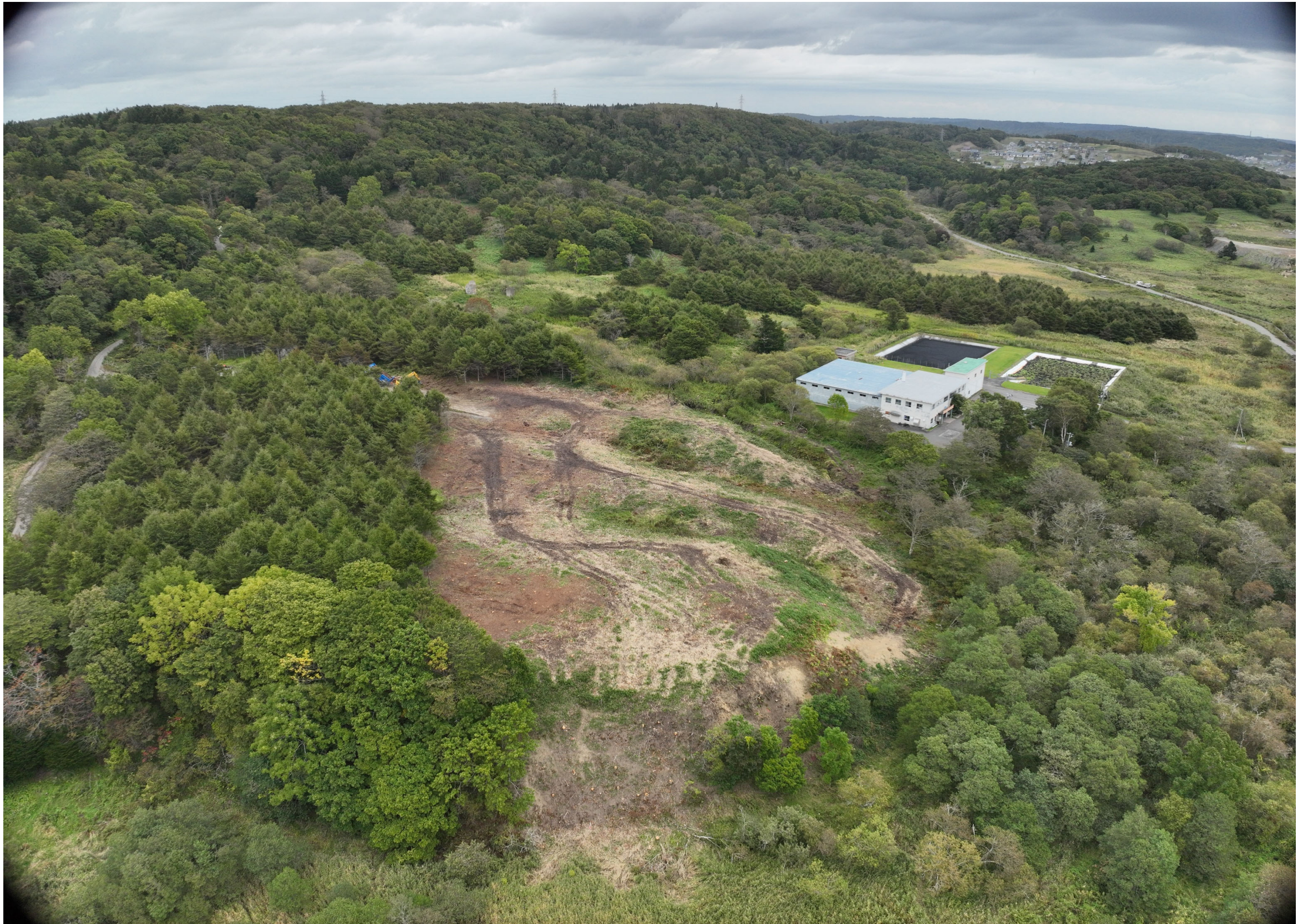
太田宏陽工区 10月空撮 起点側～
