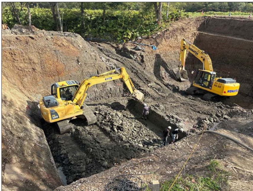
馬主来大秋線界橋災害復旧工事
