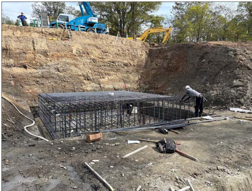
馬主来大秋線界橋災害復旧工事
