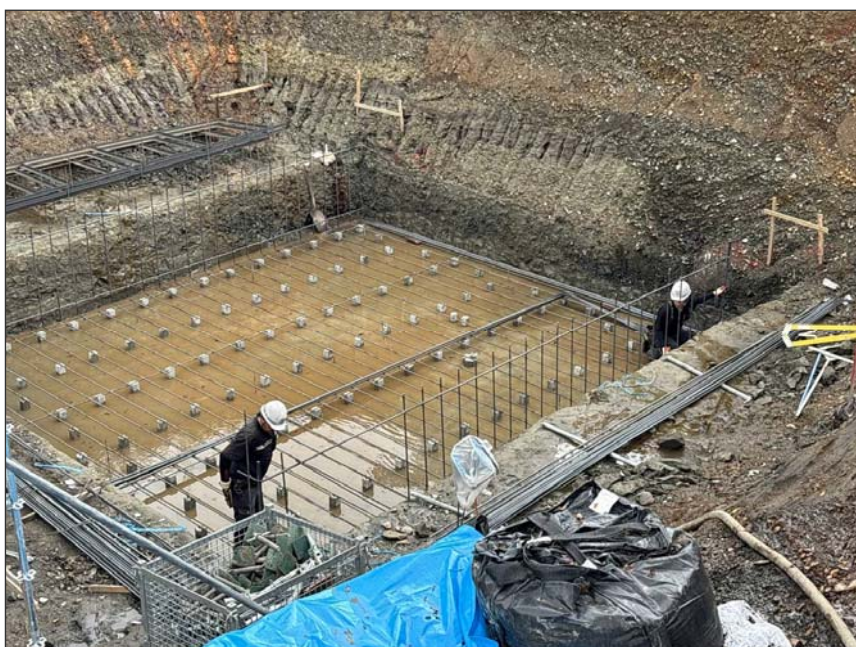
馬主来大秋線界橋災害復旧工事
