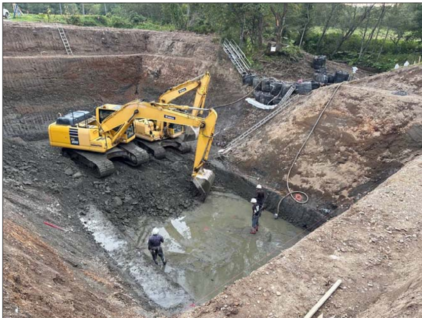
馬主来大秋線界橋災害復旧工事
