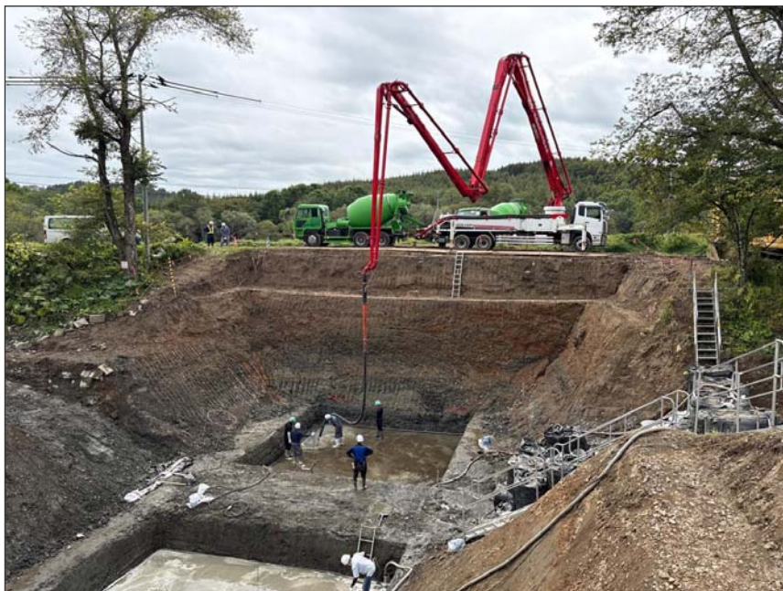
馬主来大秋線界橋災害復旧工事
