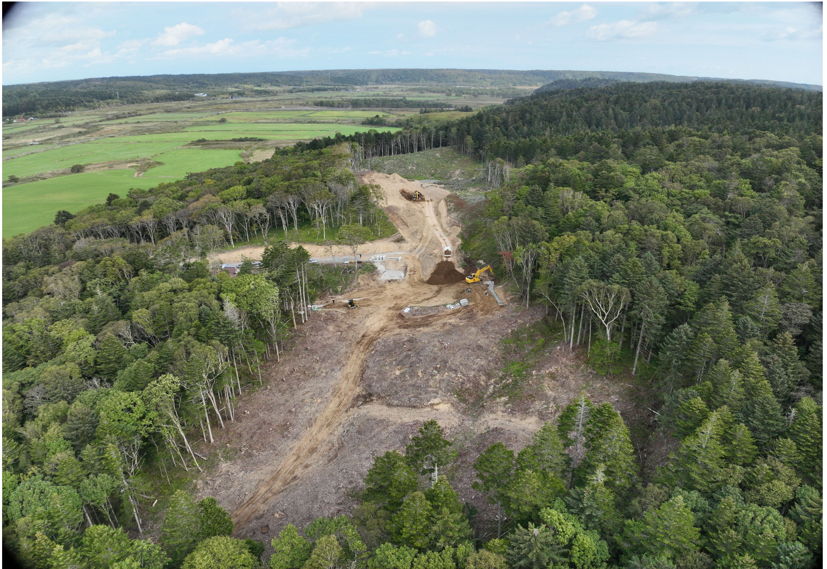
苫多西工区 10月空撮P=4000.00～
