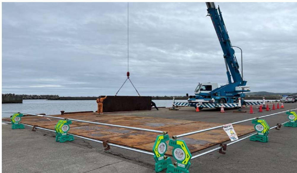
撮影年月日 令和7年8月26日 岸壁保護 敷鉄板設置
