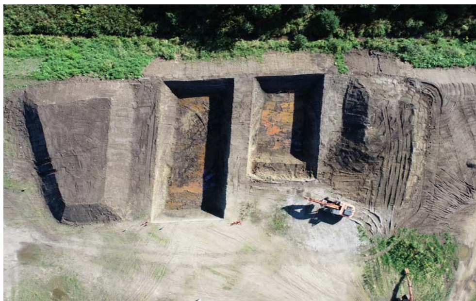
撮影年月日 令和7年8月28日 土捨場 土砂集積ピット造成中 全景
