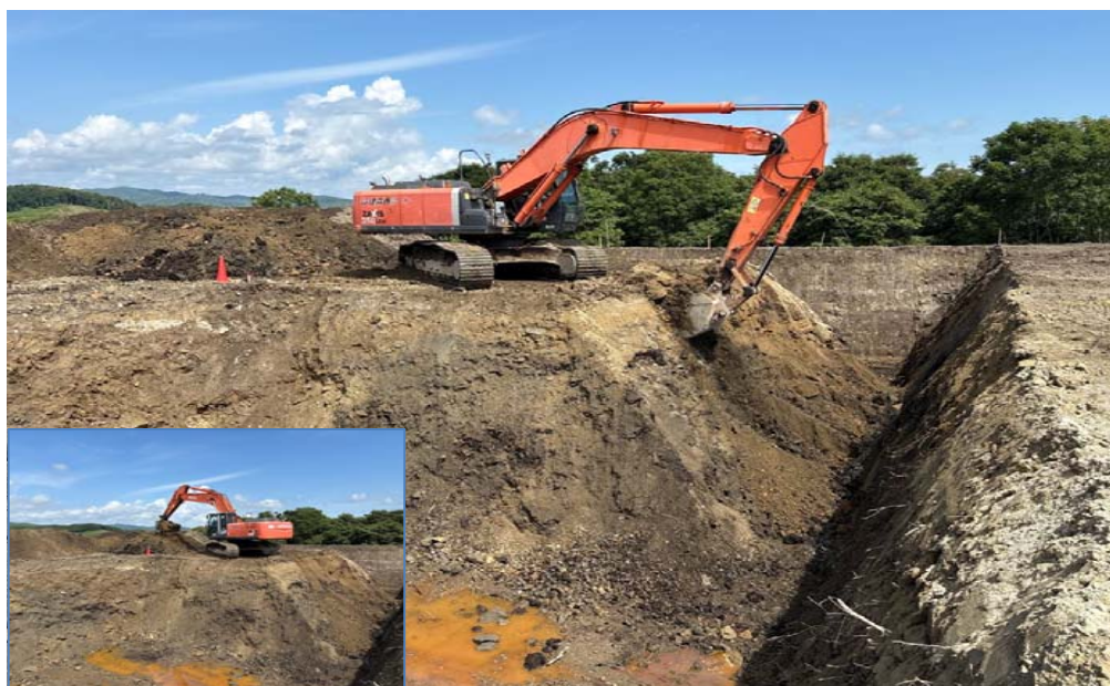
撮影年月日 令和7年8月22日 土捨場 土砂集積ピット造成状況
