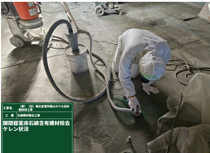
開閉器室カラクリート石棉除去
