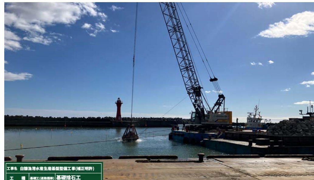
撮影年月日 令和7年10月9日 道路護岸 基礎工 基礎捨石工 投入状況
