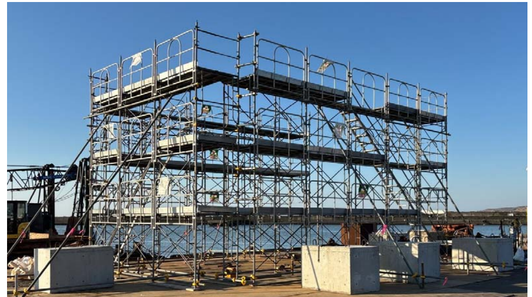
撮影年月日 令和7年10月30日 -3.5m岸壁 本体工[場所打式] 足場組立完了
