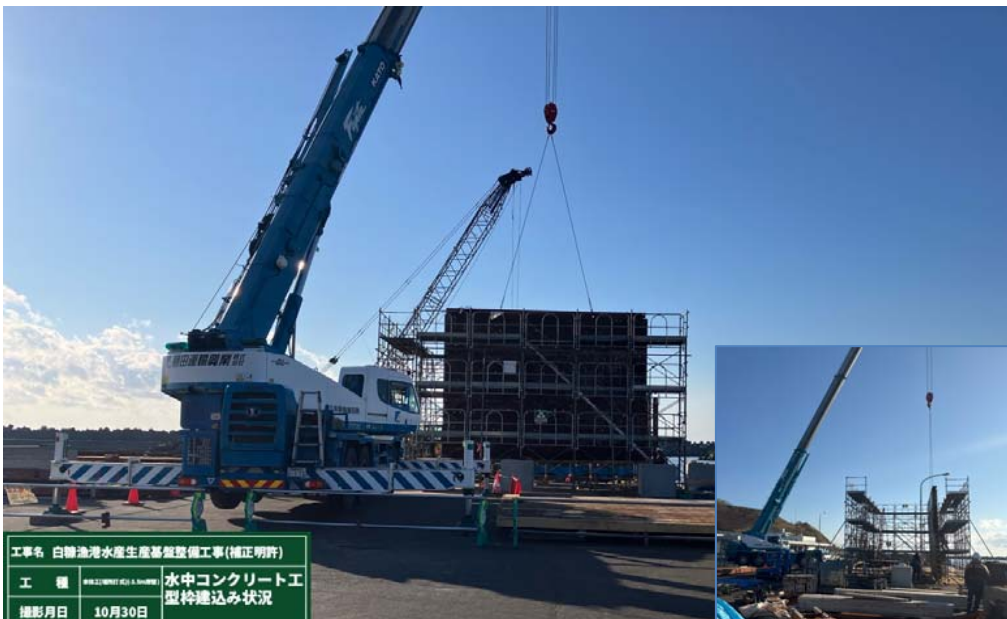
撮影年月日 令和7年10月30日 -3.5m岸壁 本体工[場所打式] 型枠建込み状況
