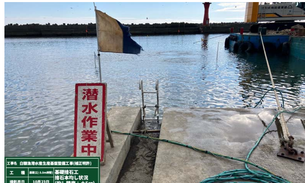
撮影年月日 令和7年10月23日 -3.5m岸壁 基礎工 基礎捨石 本均し状況±5cm
