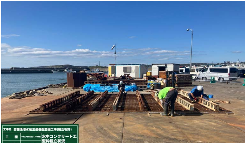
撮影年月日 令和7年10月6日 -3.5m岸壁 本体工[場所打式] 型枠組立状況
