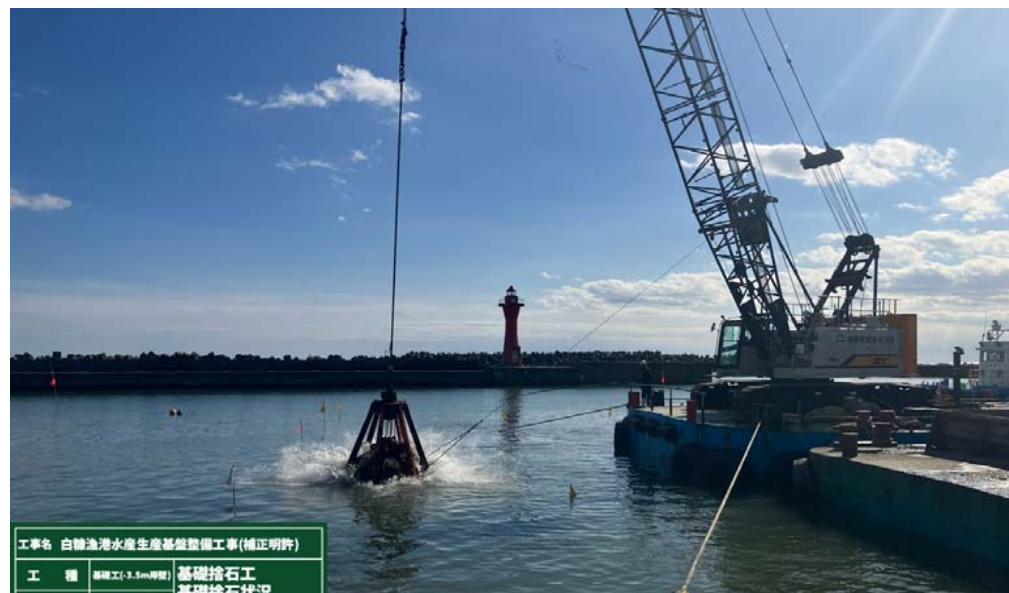
撮影年月日 令和7年10月6日 -3.5m岸壁 基礎工 基礎捨石工 投入状況
