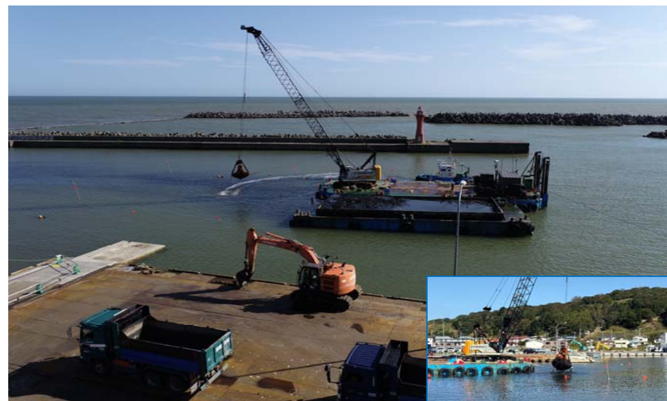
撮影年月日 令和7年9月15日 -3.5m岸壁 グラブ床掘状況
