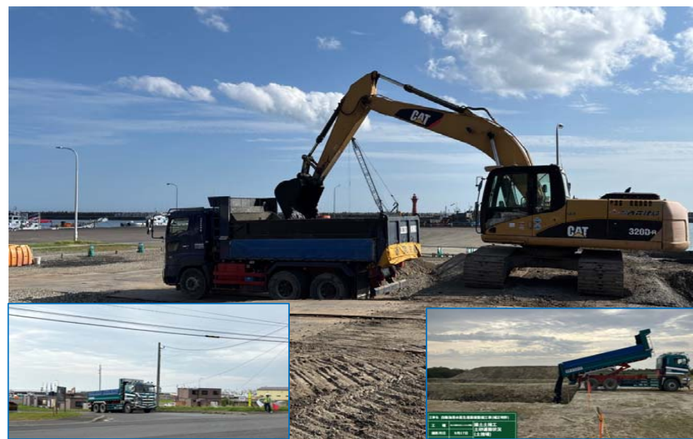
撮影年月日 令和7年9月17日 -3.5m岸壁 揚土土捨土 土砂運搬 土捨場へ
