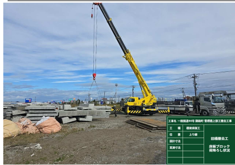
荷下し「2次破砕場」
