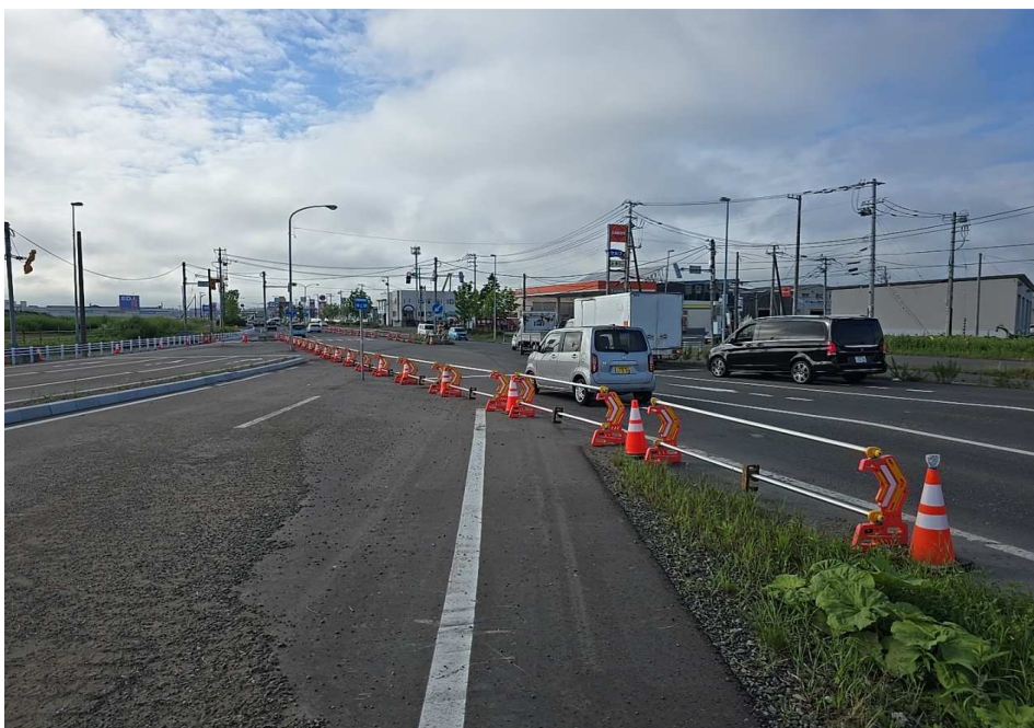
バリケード設置替え完了 (バリケード+カラーコーン)
