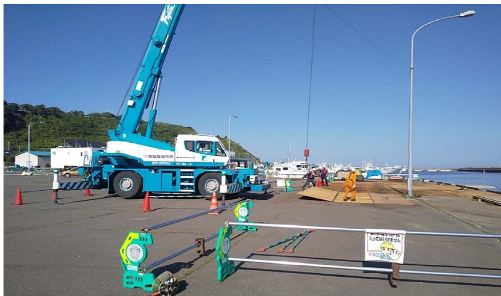
撮影年月日 令和7年7月22日 岸壁保護 敷鉄板設置
