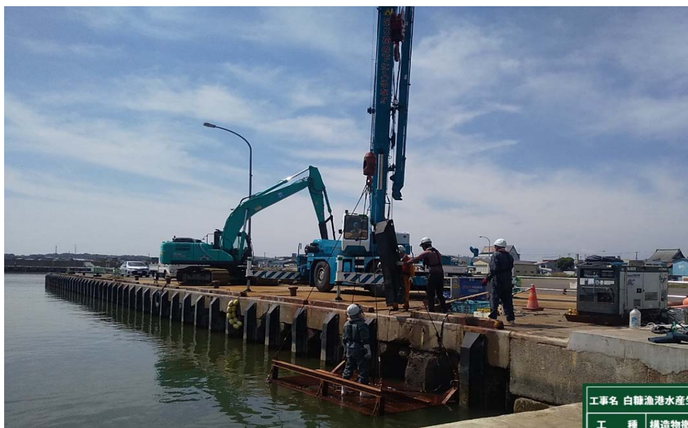
撮影年月日 令和7年7月25日 道路護岸 防舷材撤去状況
