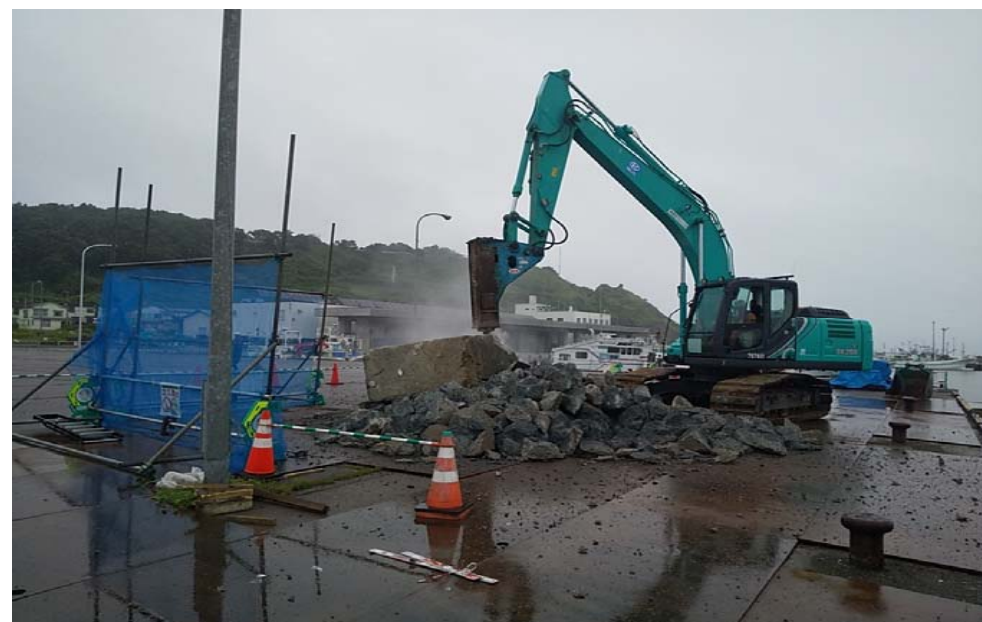
撮影年月日 令和7年7月28日 道路護岸 既設ブロック取壊し状況
