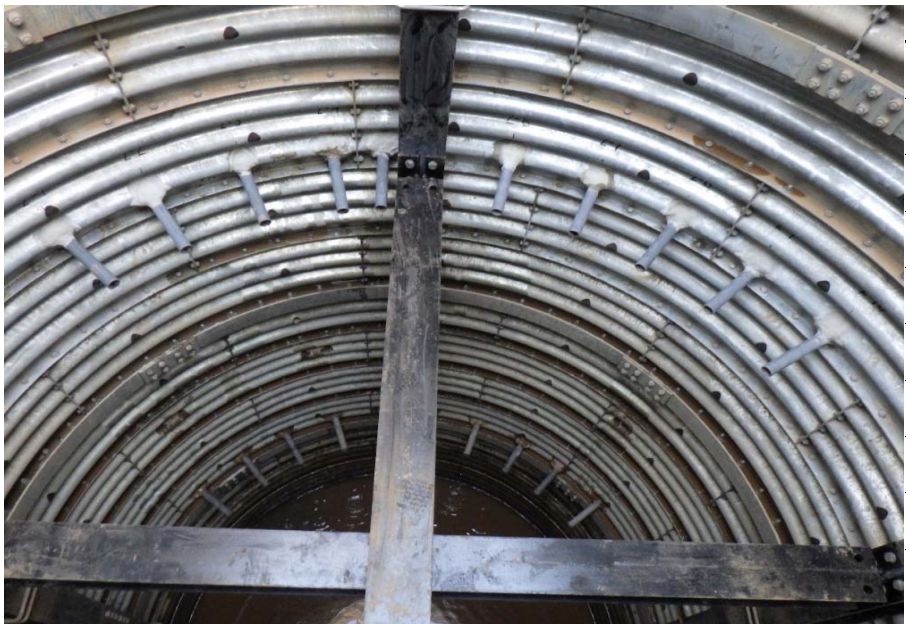
集排水ボーリング 完了
