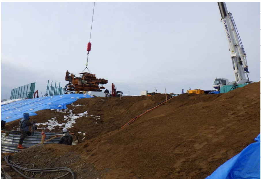
集排水ボーリング 削孔機械撤去
