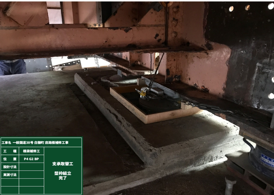
支承取替工 型枠組立完了
