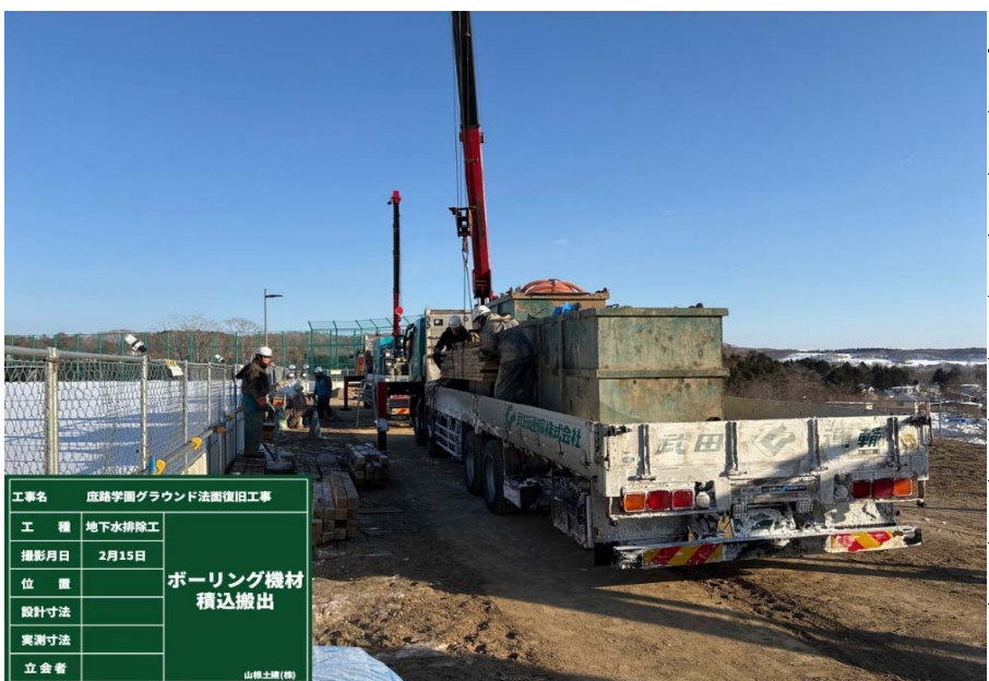
集排水ボーリング 削孔機械積込搬出
