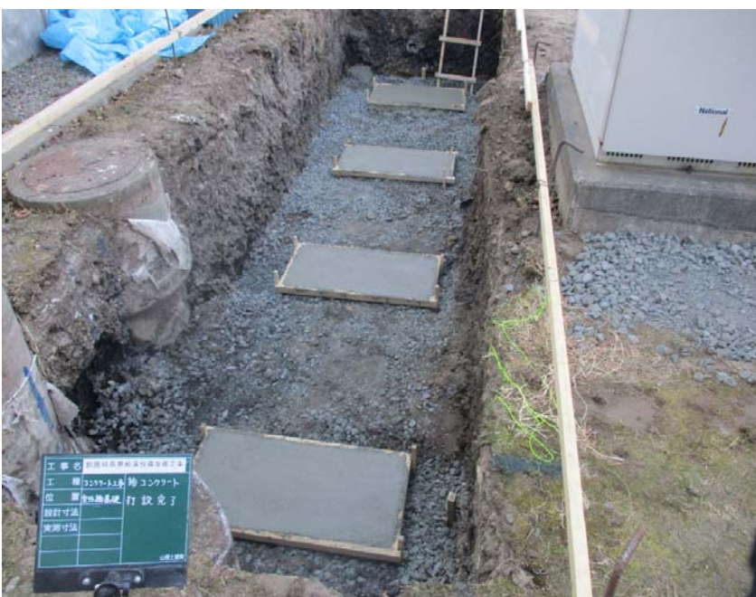
捨てコン打設完了
