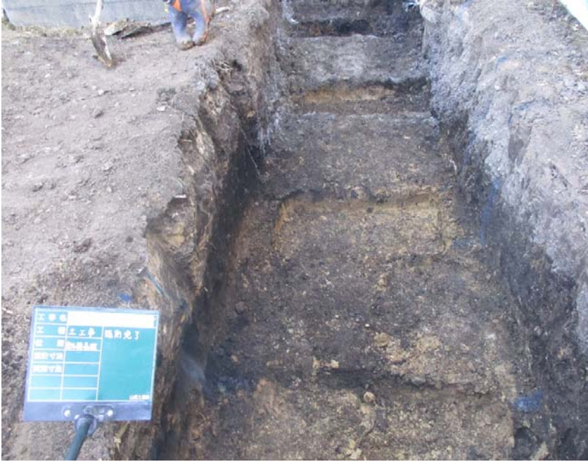
室外機基礎工事
