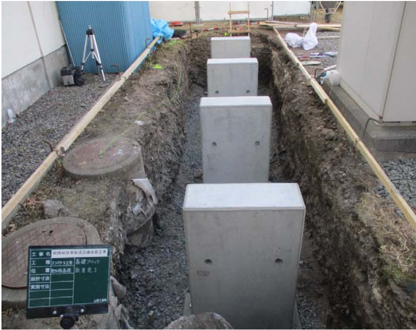
室外機基礎工事
