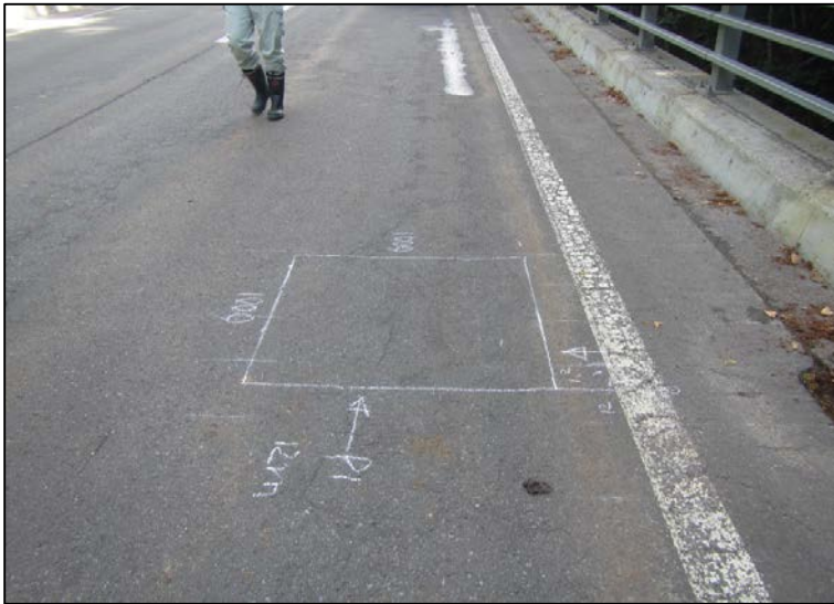
位置: R274 釧勝橋 撮影日: 令和2年8月17日
