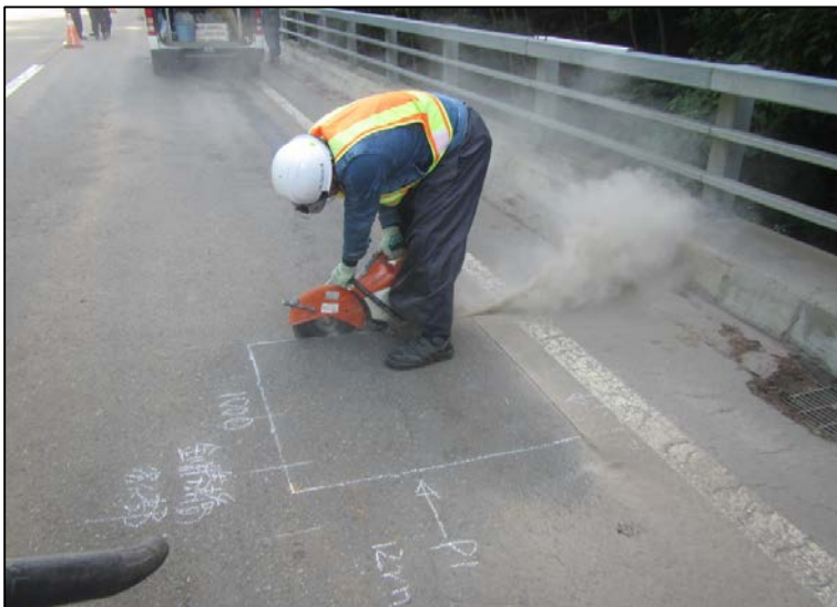
位置: R274 釧勝橋 撮影日: 令和2年8月17日
