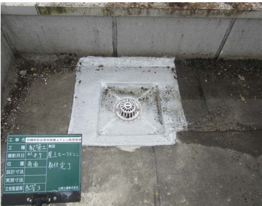
ルーフドレン取替完了
