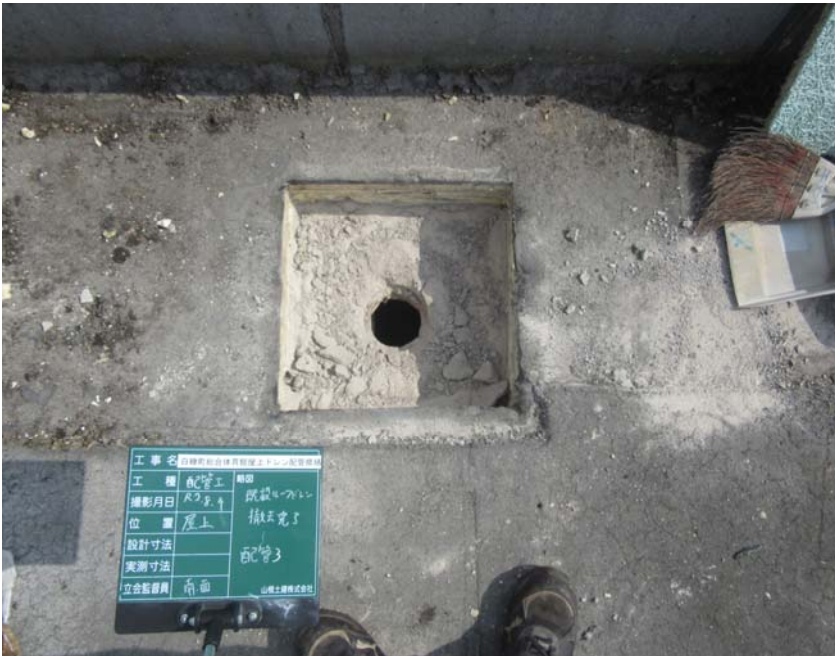
既設ルーフドレン撤去完了
