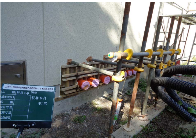
ポリコン管取付
