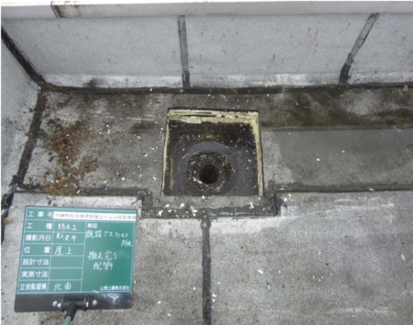
既設ルーフドレン
