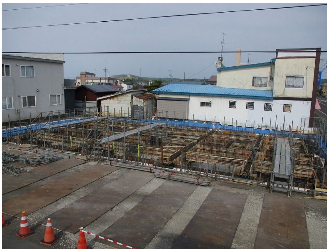
基礎型枠完了
