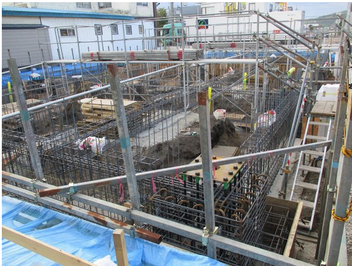
基礎型枠完了
