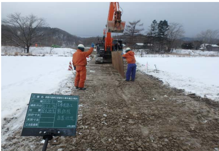
位置： 撮影日： 宮木工区 工場道路工 敷鉄板設置
