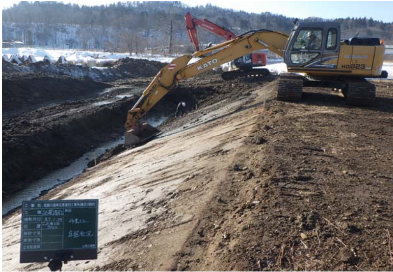
位置： 撮影日： ふ化場工区 法面整形
