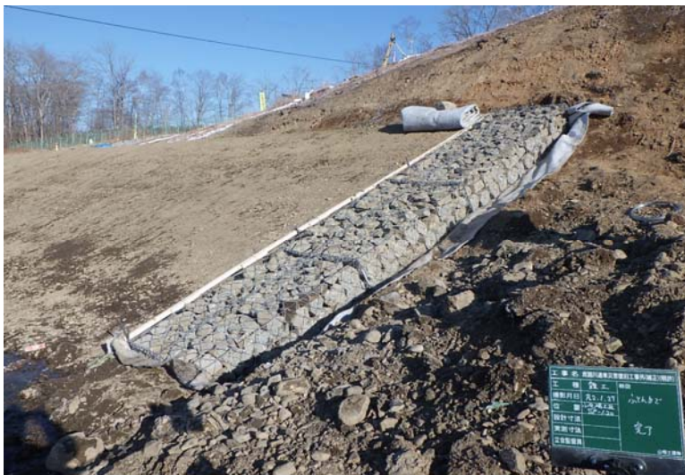
位置： 撮影日： ふ化場工区 ふとんかご設置完了 起点側
