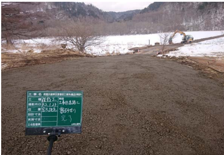
位置： 撮影日： 宮木工区 工場道路工 敷砂利完了
