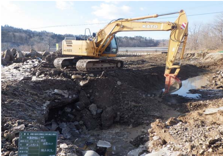
位置: 撮影日: ふ化場工区 既設ブロック撤去
