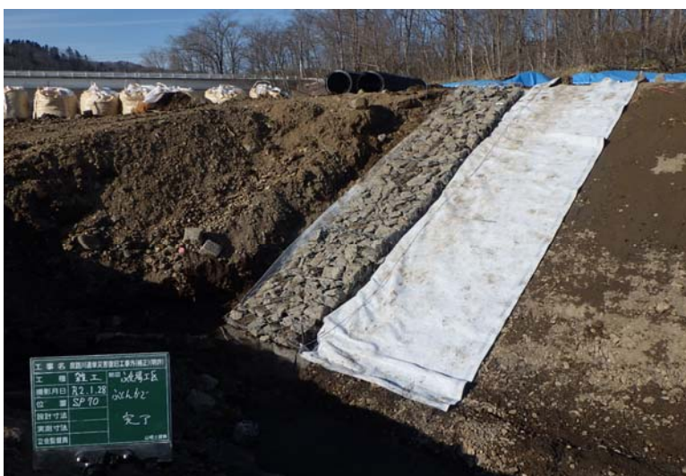
位置： 撮影日： ふ化場工区 ふとんかご設置完了 終点側
