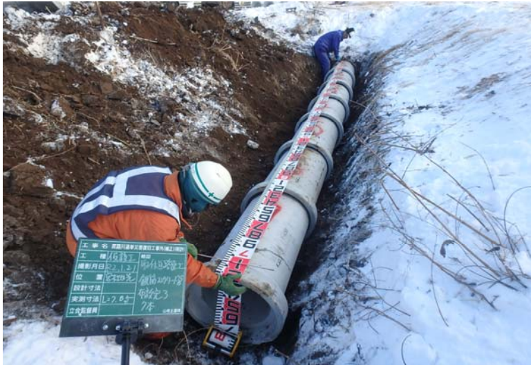
位置： 撮影日： 宮木工区 工場道路工 コンクリート管布設完了
