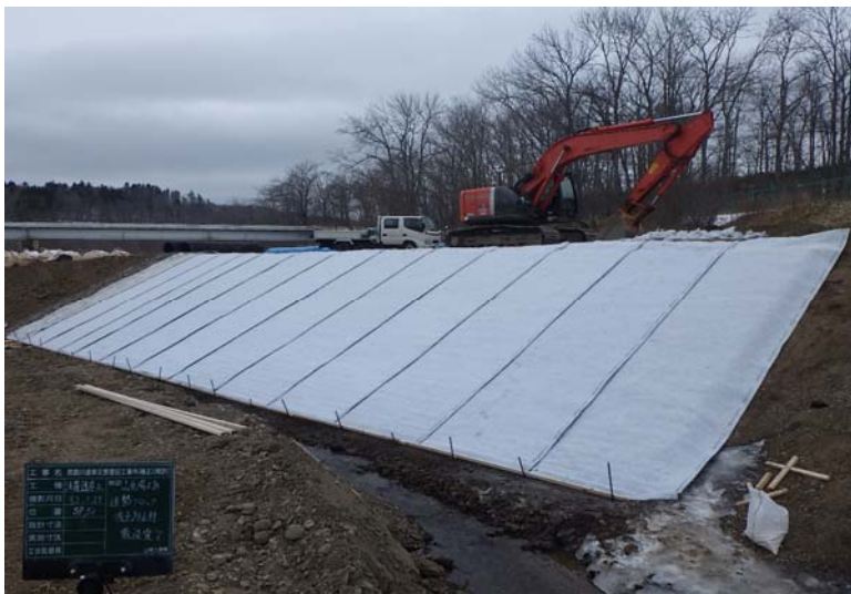
位置： 撮影日： ふ化場工区 吸出し防止シート
