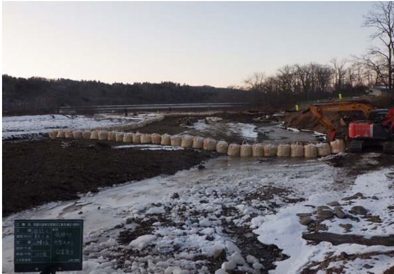
位置: 撮影日: ふ化場工区 大型土のう設置完了
