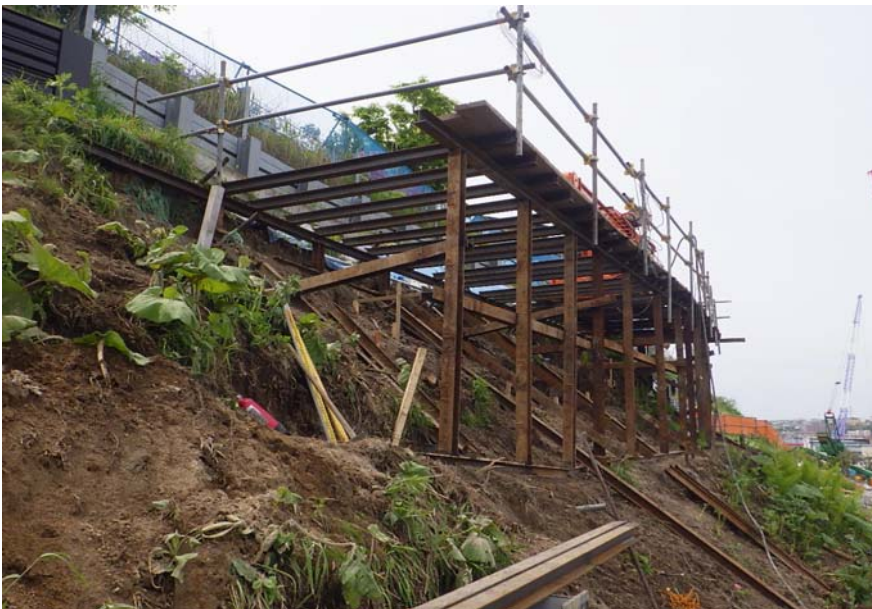
位置： 撮影日： 材木町 2工区2段目 足場設置
