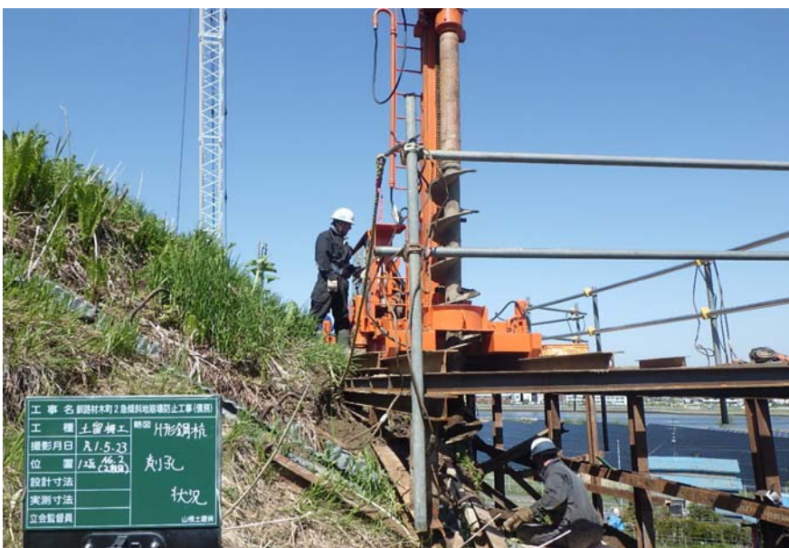
位置: 撮影日: 材木町 1工区2段目 削孔状況
