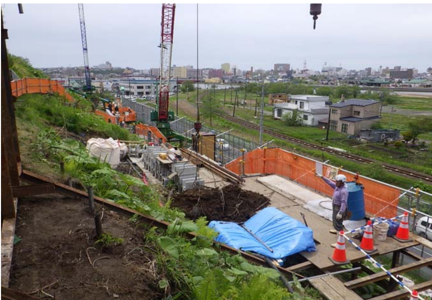
位置： 撮影日： 材木町 土砂運搬状況
