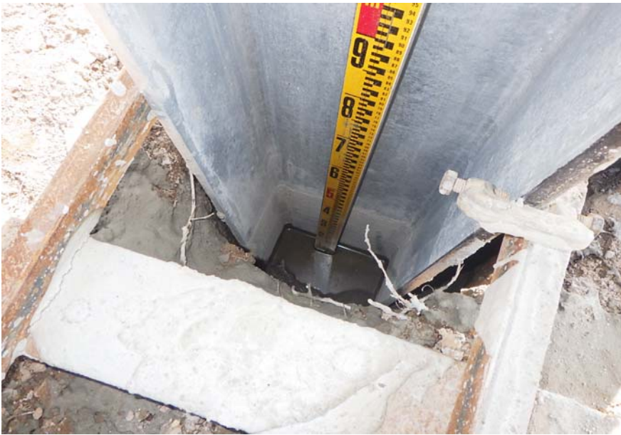
位置： 撮影日： 材木町 1工区2段目 モルタル打設完了
