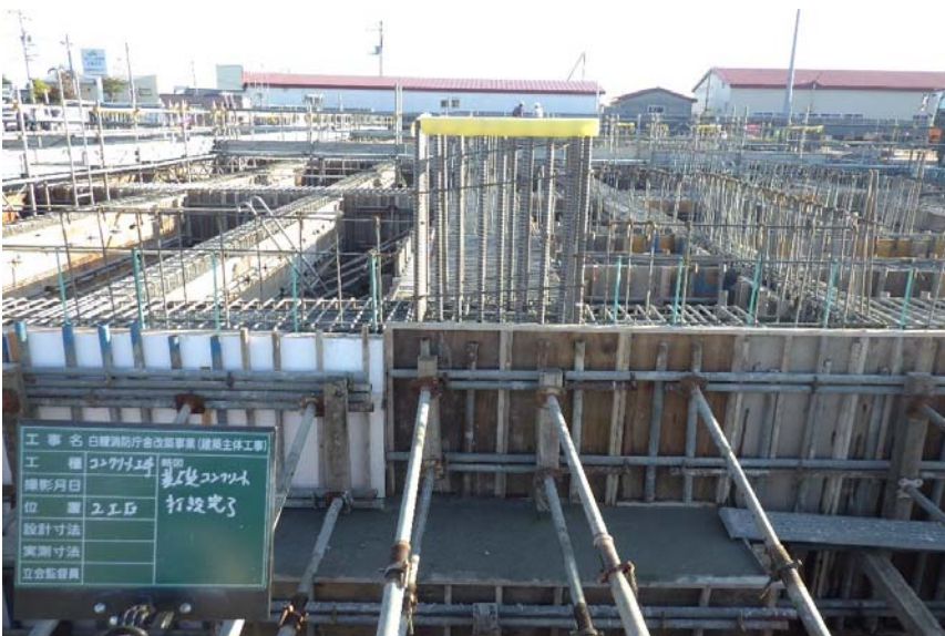
基礎コンクリート打設完了
