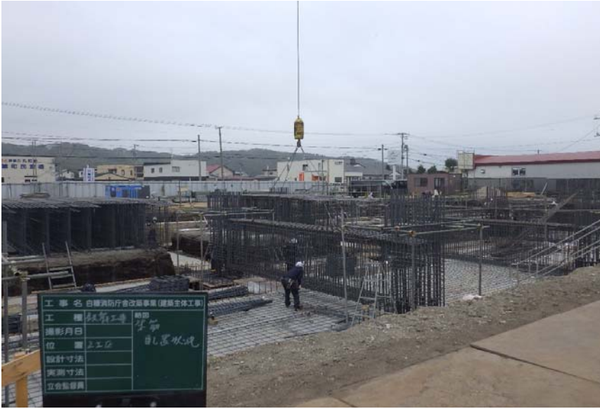
基礎鉄筋組立状況
