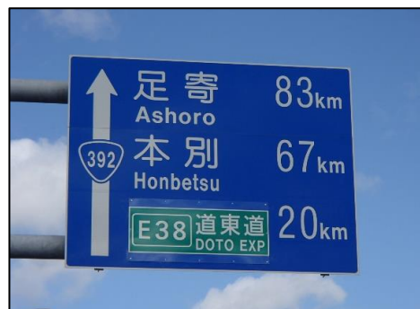
標識板補修(修正板設置)完了
